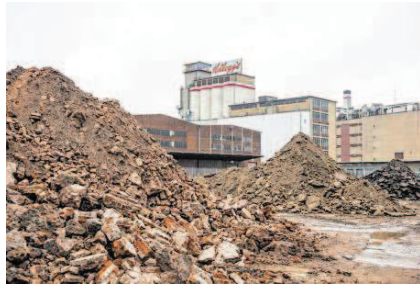
Das Kellogg-Areal wird sich verändern – wie die ganze Überseestadt. Der Abriss weiterer Gebäude ist aber erst für 2020 geplant.
