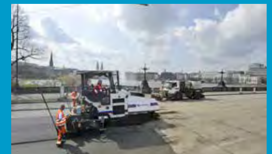
Örtliche Bauüberwachung S. 56
