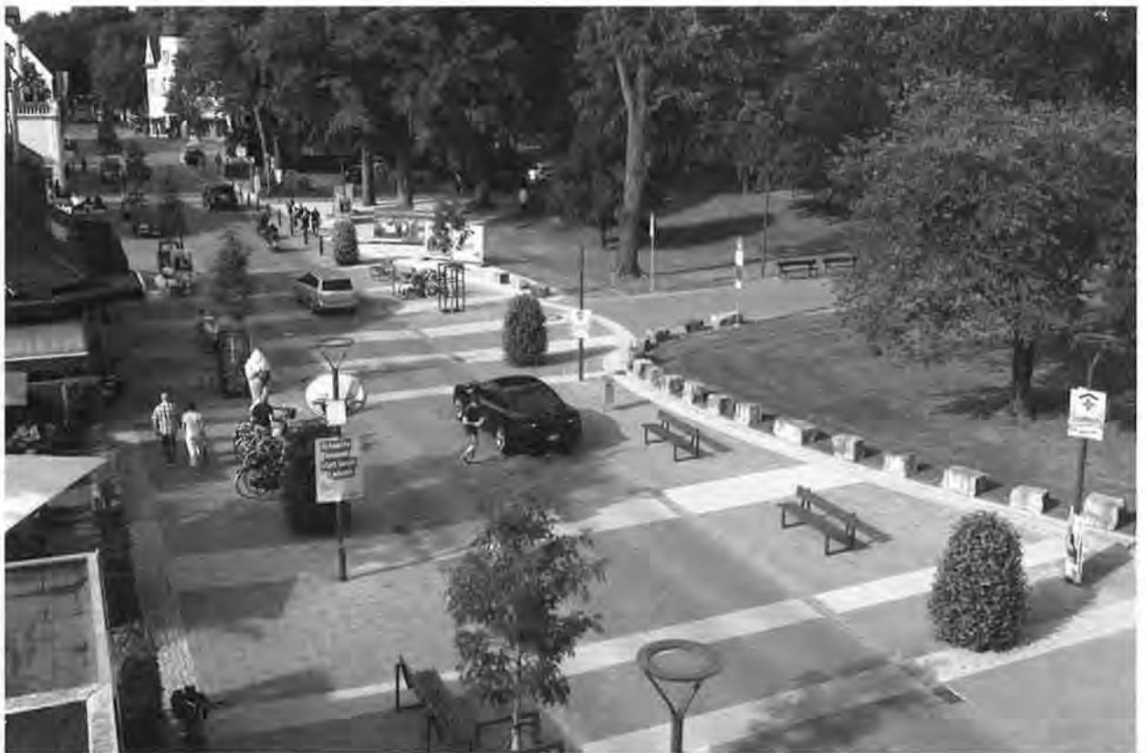
Verkehrsberuhigter Geschäftsbereich Frankfurter Straße, Bad Rothenfelde (Foto: SHP Ingenieure)
