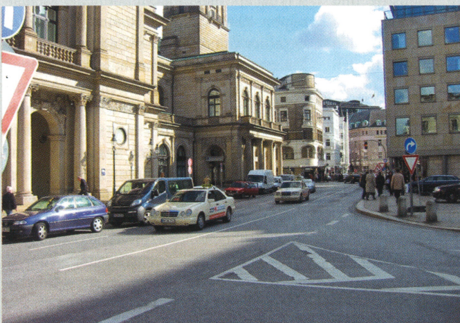
Bild 9: Ist-Zustand BID Nikolaiquartier, Adolphsplatz (h. o. dieter schoppe + partner, freiraumplanung)
