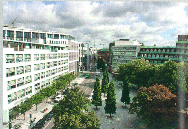
Bild 6: BID Hohe Bleichen/Heuberg nach den baulichen Maßnahmen (Breimann & Bruun)
